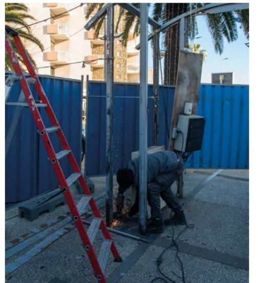
**Wagons de l'avenue Lyautey :** réfection de la structure métallique et remise à neuf des éléments en bois, mise en place de Led pour assurer une faible consommation d'énergie et barrières de protection pour le public pendant cette phase de travaux.
